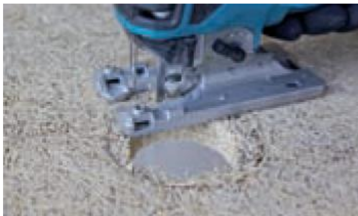
Вырезание отверстия с помощью ручного лобзика. Видимая сторона плиты смотрит вниз
