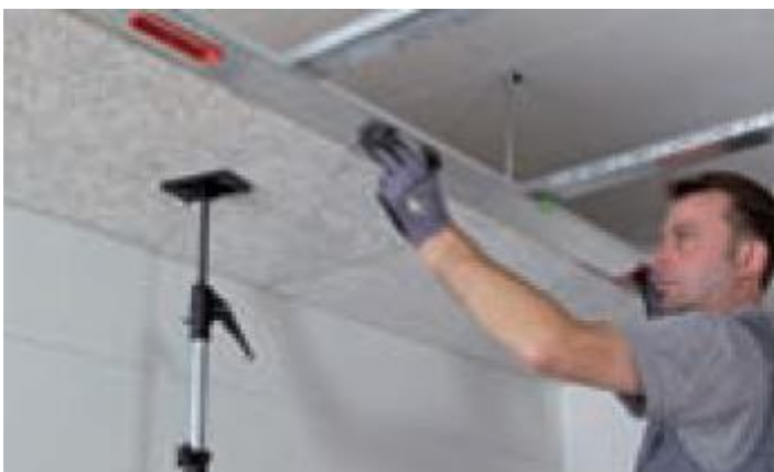
Проверьте уровень плит в плоскости. Кромки плит должны попадать посередине профиля, так чтобы края плит не висели в воздухе! При монтаже квадратных плит учитывайте направление стрелок на тыльной стороне плит
