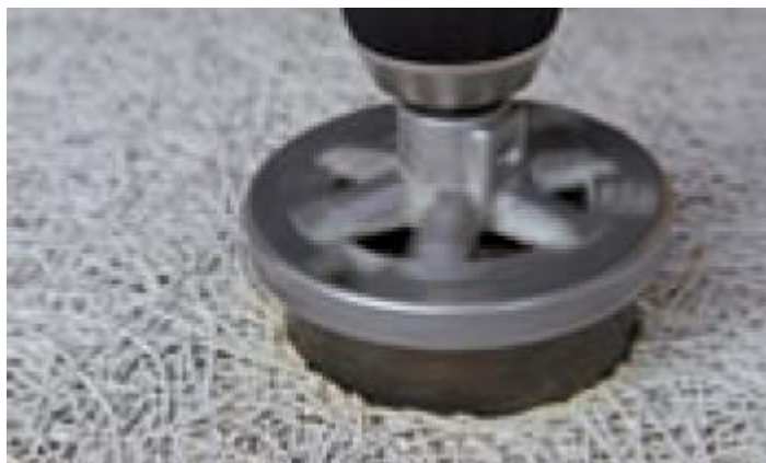
Вырезание отверстия для точечного светильника с помощью бора. Видимая сторона плиты смотрит вверх
