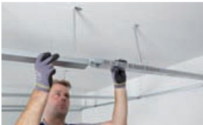
Желательно соединять CD-профили со смещением (в шахматном порядке). На месте стыка требуется дополнительный подвес
