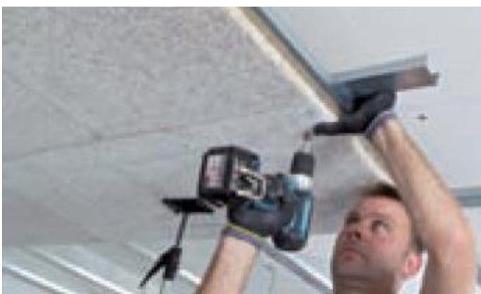
При монтаже плиты прижимайте ее к профилю. Не оставляйте зазоры между профилем и плитой. Начинайте монтаж с середины помещения. Выполняйте работу только чистыми руками и инструментами
