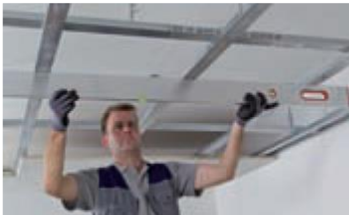
Выставьте конструкцию в плоскости с помощью лазерного уровня
